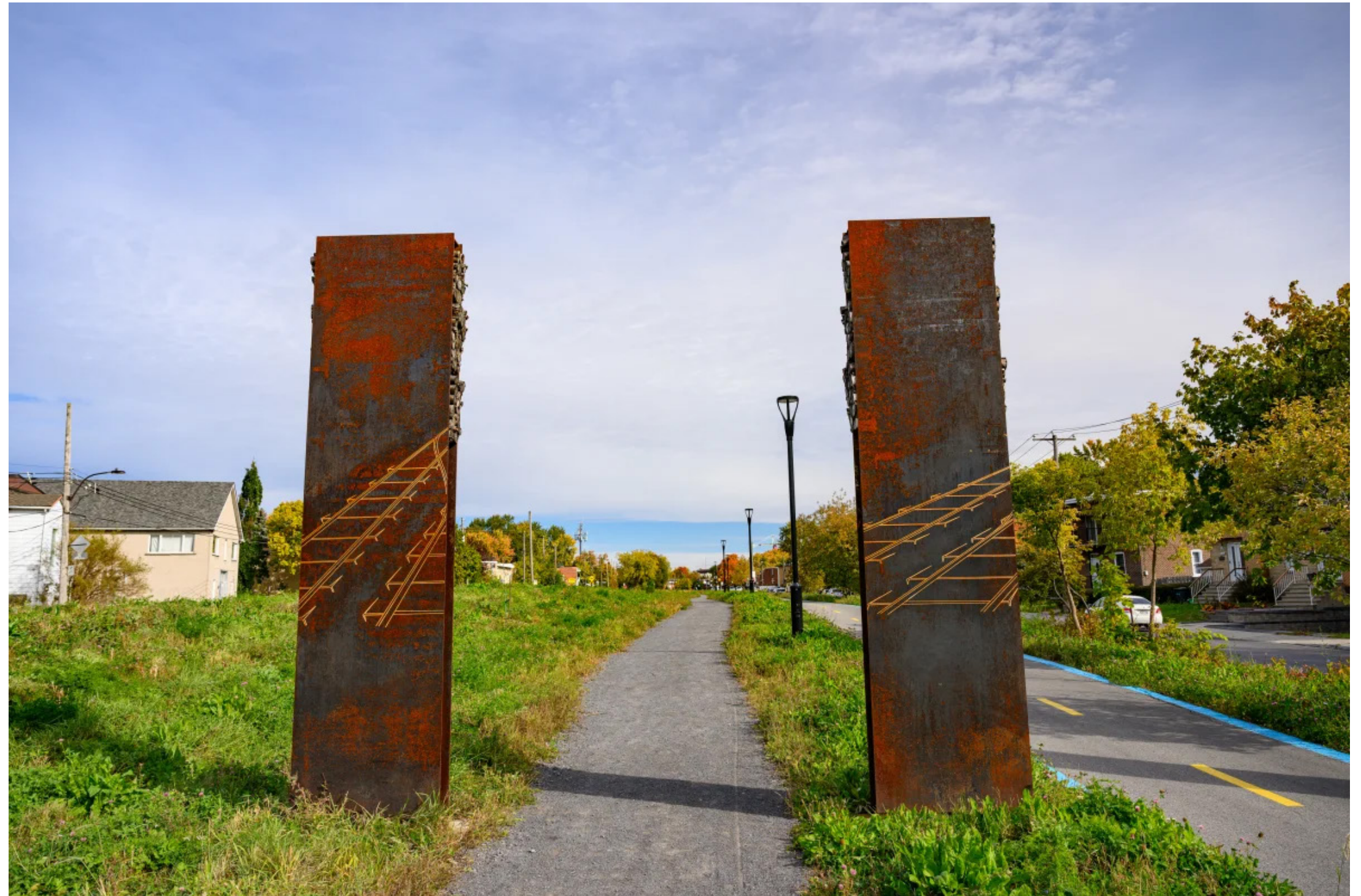
Sentiers pédestres et polyvalents situés sur une ancienne emprise ferroviaire, aujourd'hui le parc de la Traversée à Montréal Ville de Montréal, 2024
